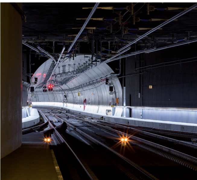
Einfahrt vom Weinbergtunnel in den Bahnhof Löwenstrasse
