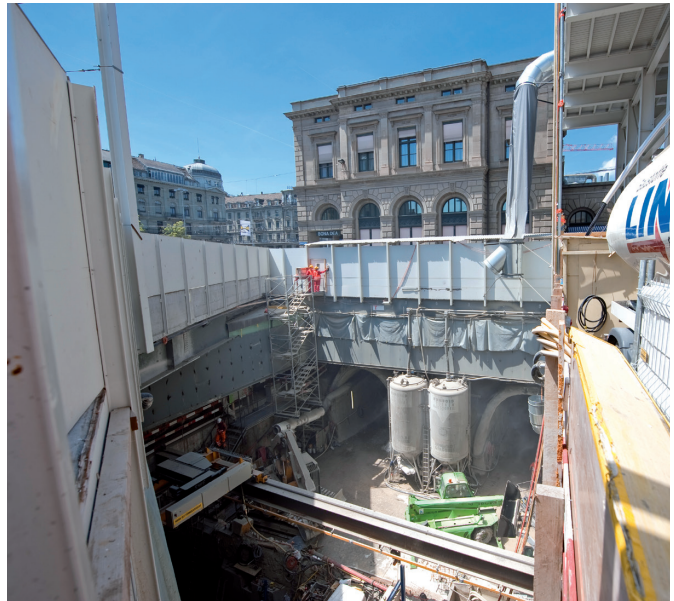
Schacht Südtrakt: Längsstollen zur Unterquerung des historischen Südtraktes
